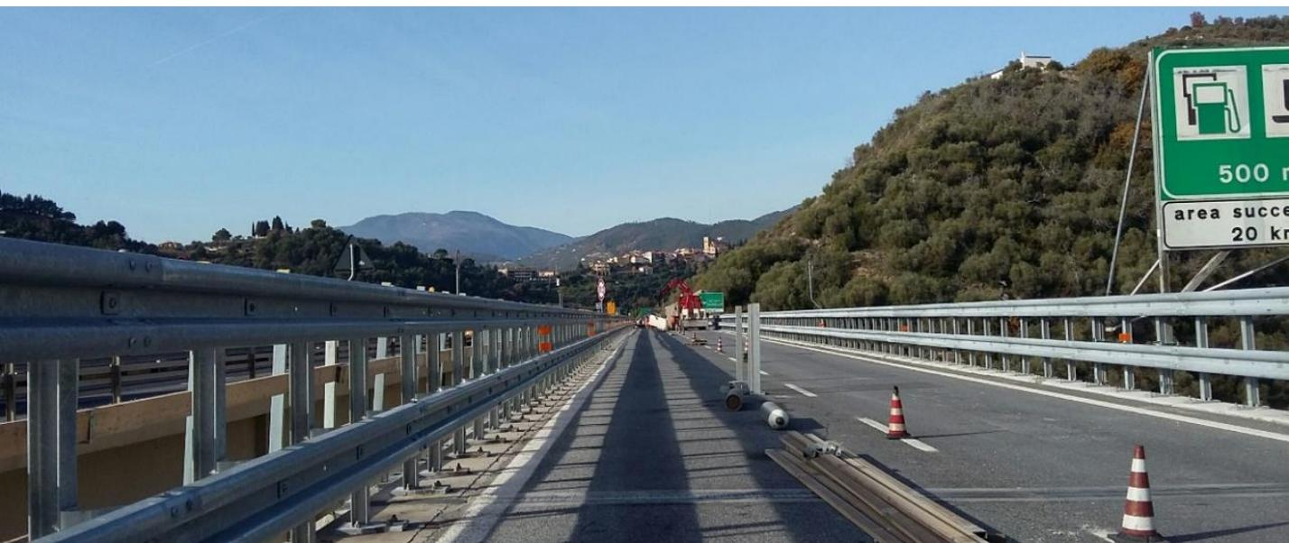
Tratta A10 – Barriere ad alto contenimento viadotto Lagoscuro
